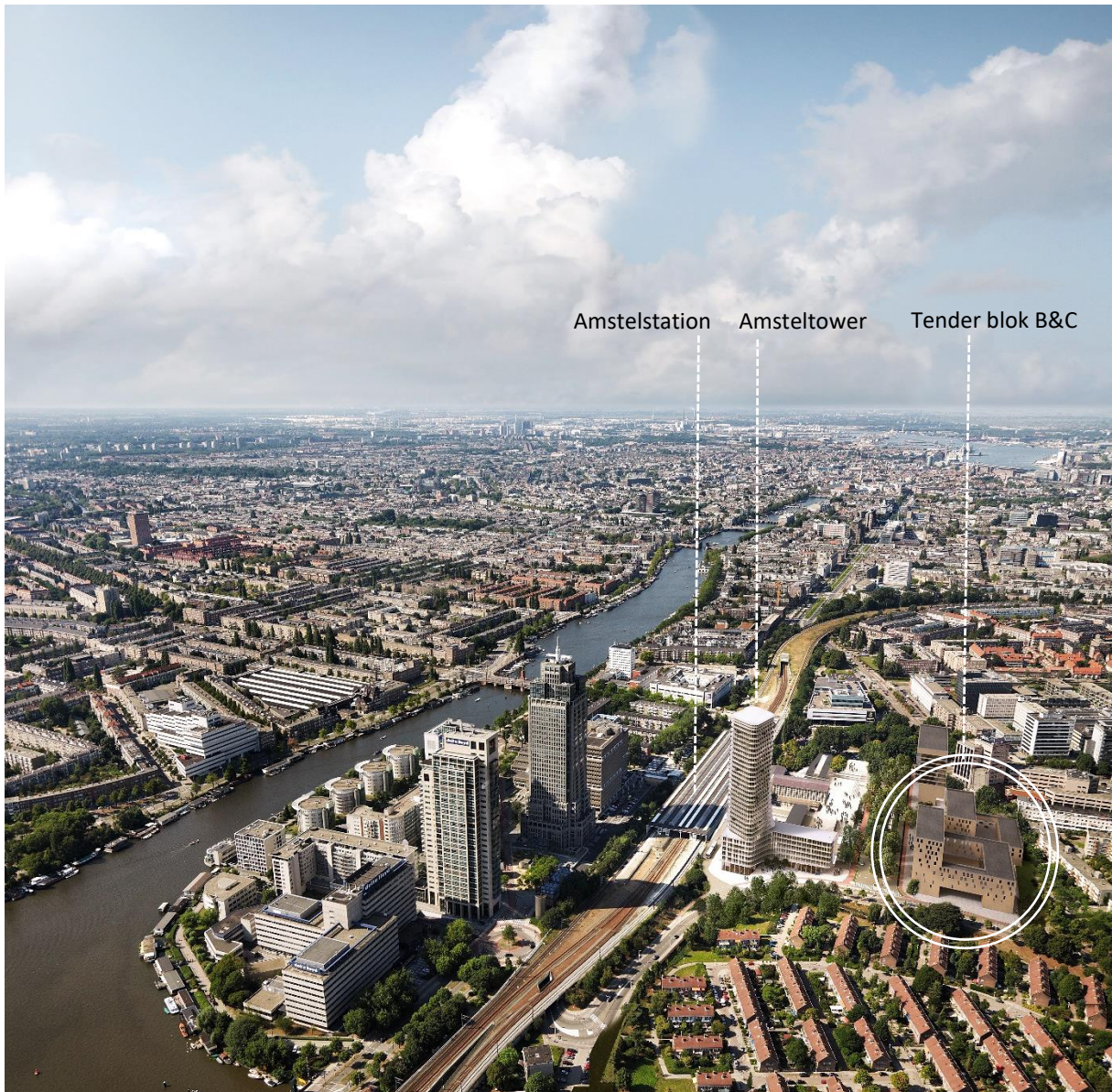
Figuur 19: Positionering van het blok B & C, in omgeving Amstelstation, Amsterdam. Bron: Provast, Amsteltower artist impression.
