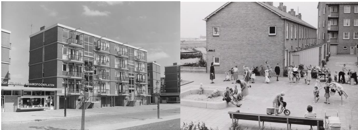
Figuur 2.2 Links: woningen aan de Nolensstraat in Geuzenveld. Rechts: een speelplek met woningen langs de nog aan te leggen Burgemeester Röellstraat in Slotermeer. Bron: https://beeldbank.amsterdam.nl/ , (opgehaald op 26 augustus 2018)
