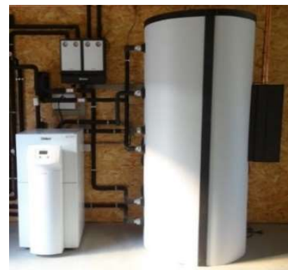
Figuur 24: Warmtepompinstallatie
