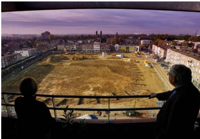
Bouwwerkzaamheden in het Stadshart van Geleen, 2007 (fotograaf: Peter Schols)
