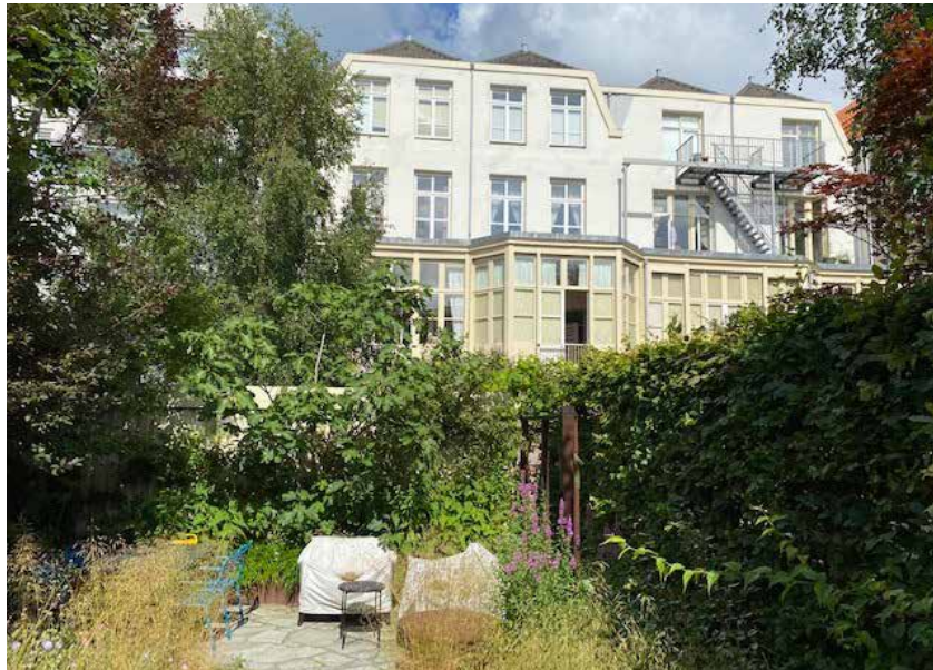
Afbeelding 4.14: Uitzicht vanuit de gemeenschappelijk tuin op het gebouw waarin de woongemeenschap Anna Paulowna is gevestigd. Bron: A.M. Kramer (2021)
