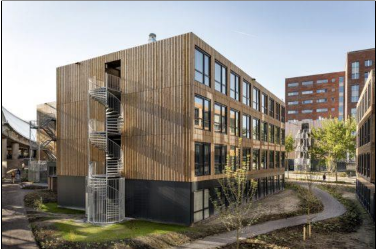
Tijdelijke studentenwoningen van Jan Snel: het WASA Student Village in Amsterdam. Foto: Cojan van Toor
