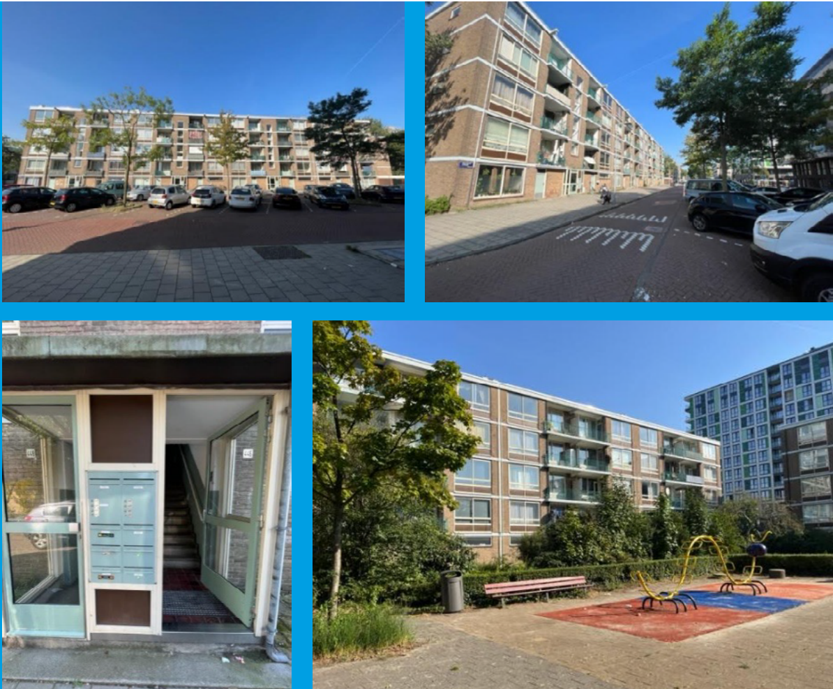
Foto's 4. 1 Observatie van de gebouwen aan de Maassluisstraat. Eigen foto's.
