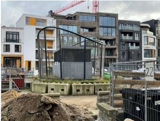
Figuur 24: Tunneltechnische installatie boven de tunnel (Soeting, 2023)
