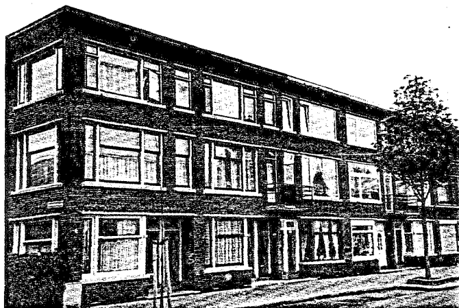
etagewoning, gebouwd vóór 1950, vlak dak
